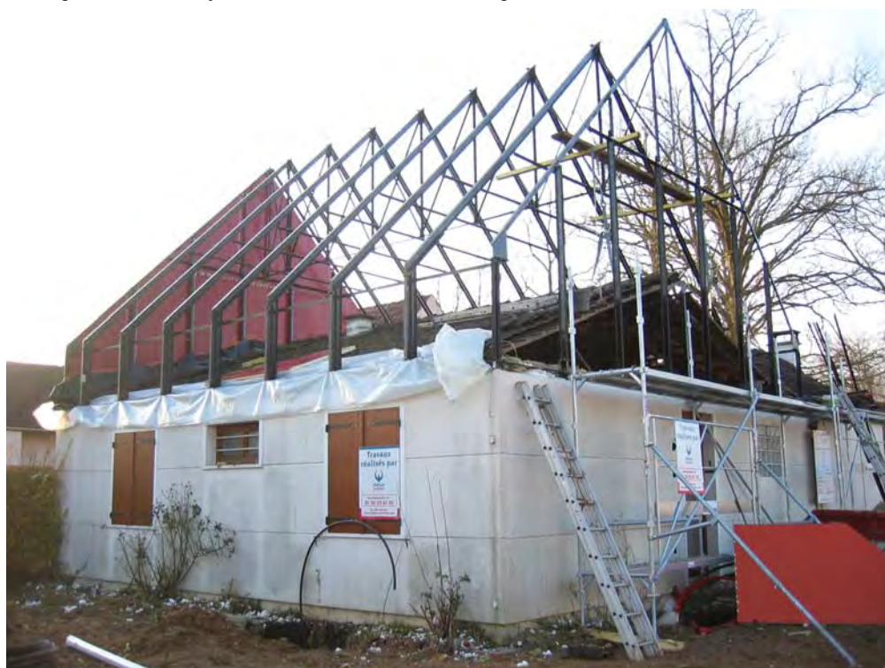
Pose d'une nouvelle charpente avant dépose de l'ancienne © Phénix évolution
