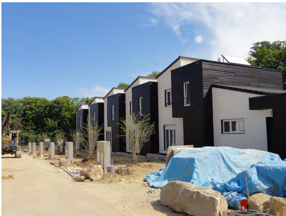
Opération CQFD de Vert-Saint-Denis
