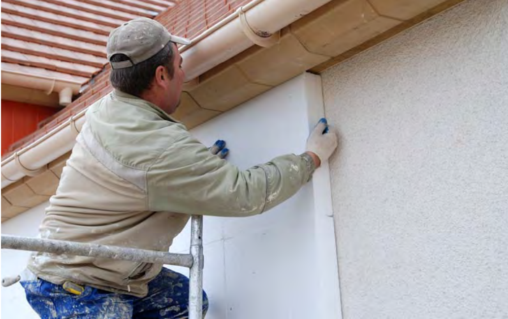
Pose de l'isolation par l'extérieur © Phénix évolution
